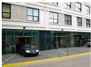
De Witte Keizer in Rotterdam heeft een compacte automatische parkeergarage die verkeersruimte tot een minimum beperkt.
