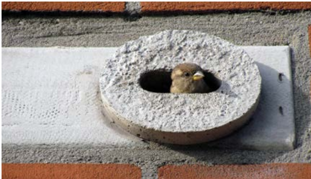
integrale verwerking van nestkast in de gevel
