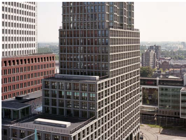
heldere opbouw van het volume naar boven door middel van verjonging. bouwblok Den Haag; architect: Rapp + Rapp
