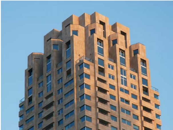
een kroon opgebouwd uit verschillende vollumes en buitenruimtes met een duidelijke verticale richting en verjonging naar boven toe. New Orleans - SiZa - Rotterdam
