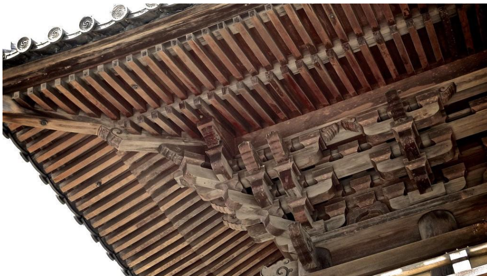
Figuur 5: Houten verbindingen in een pagode (Nipponia, 2005)
