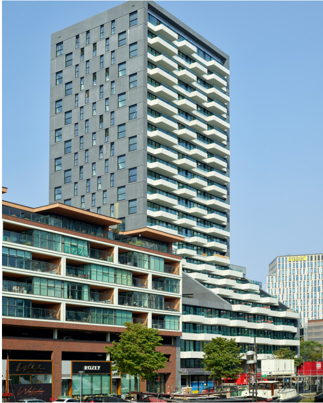
20.000m 2 | oplevering oktober 2019 | 70m hoog | Barcode Architects
