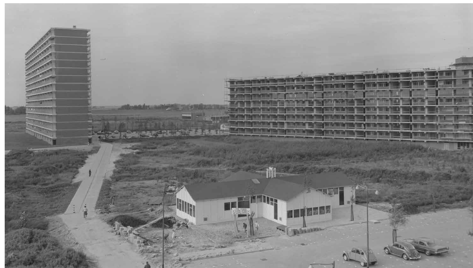
Het Rotterdamse Ommoord, de eerste hoogbouwwijk van Nederland, in aanbouw. 20 augustus 1968
