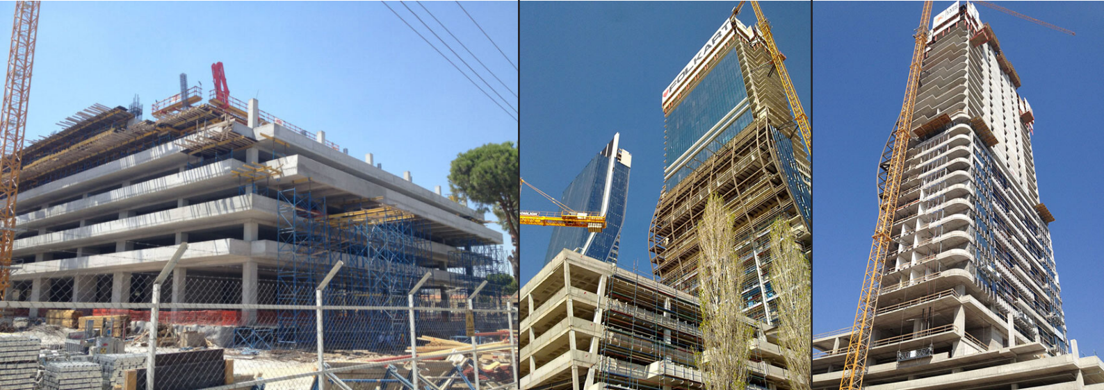
► Verschillende fases van de Folkart Towers in aanbouw
